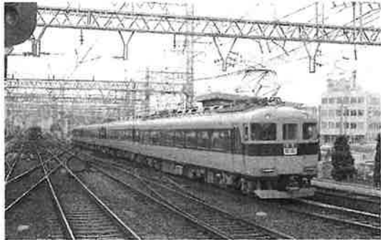
写真序-1 複雑な配線が特徴の大和西大寺駅構内 1984年9月 大和西大寺駅 撮影：著者
