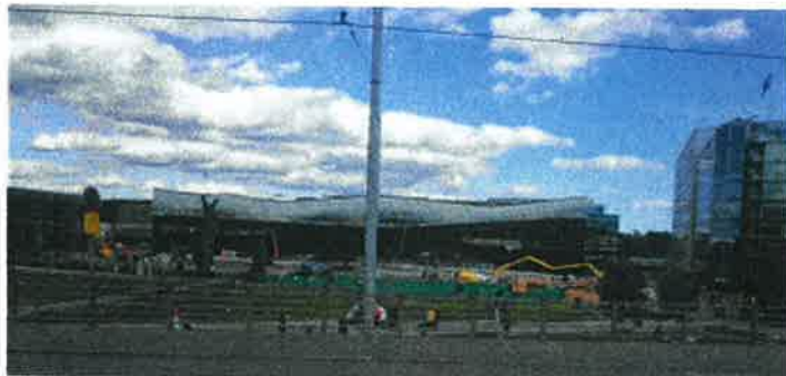
【写真: 建設中のヘルシンキ中央図書館 Oodi 2018年8月22日小社編集部=撮影】
